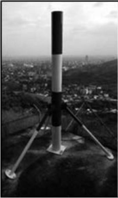
Figura 28. Materialización tipo mástil terminada.
