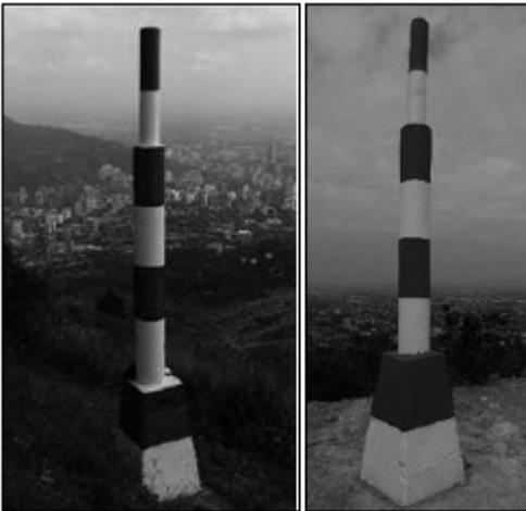
Figura 27. Materialización tipo obelisco terminada.
