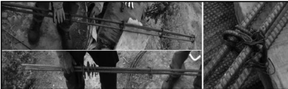
Figura 18. Armado hierro, base plato de acero (rosca hembra en el centro).
