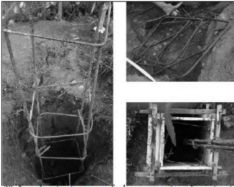
Figura 20. Armado estructura y encofrado prisma rectangular recto y tronco de pirámide.
