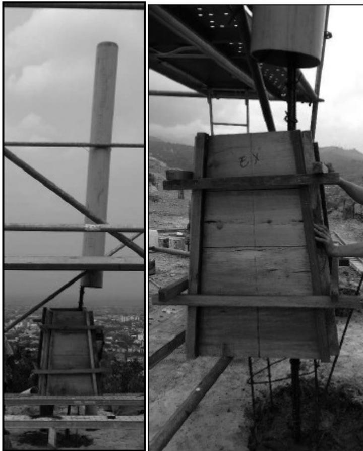
Figura 22. Hincado de la varilla de hierro con tubo PVC.
